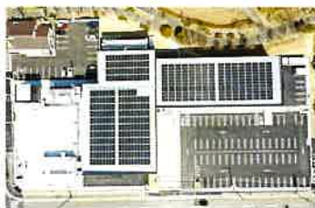
【太陽光パネル】
